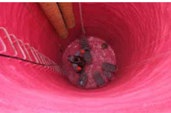
Sanierung eines Pumpenschachtes
